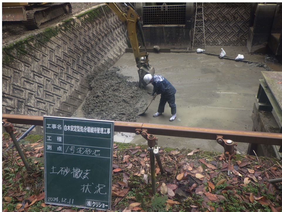
沈砂池 土砂撤去状況 (2024年12月10日～2024年12月11日)
