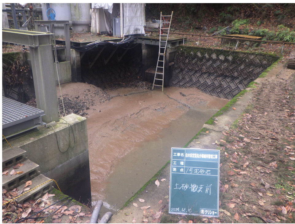
沈砂池 土砂撤去前 (2024年12月10日～2024年12月11日)
