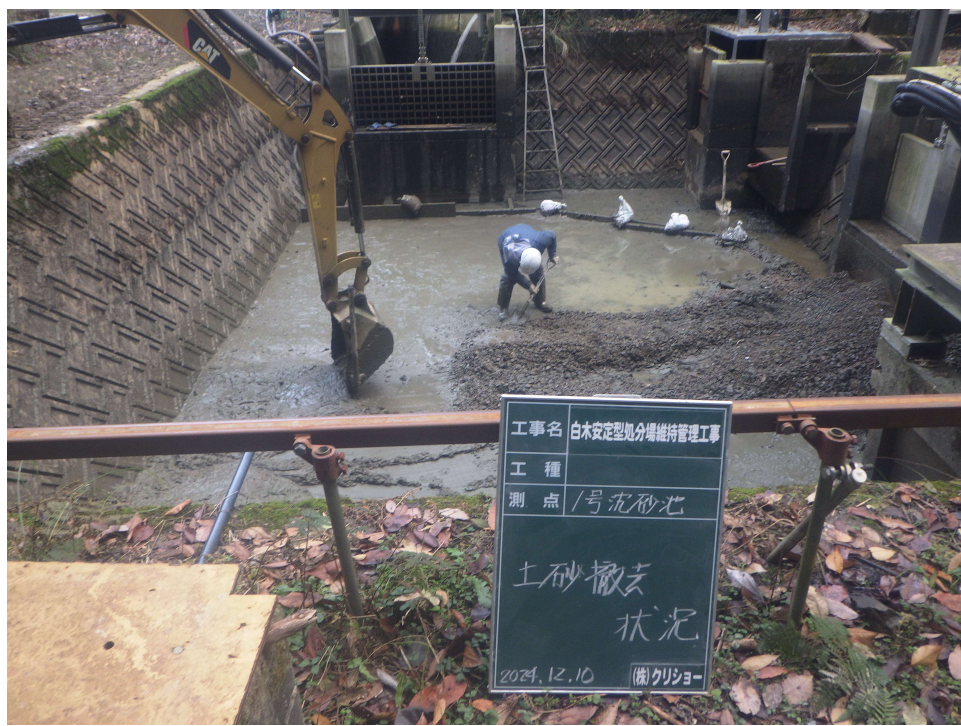
沈砂池 土砂撤去状況 (2024年12月10日～2024年12月11日)
