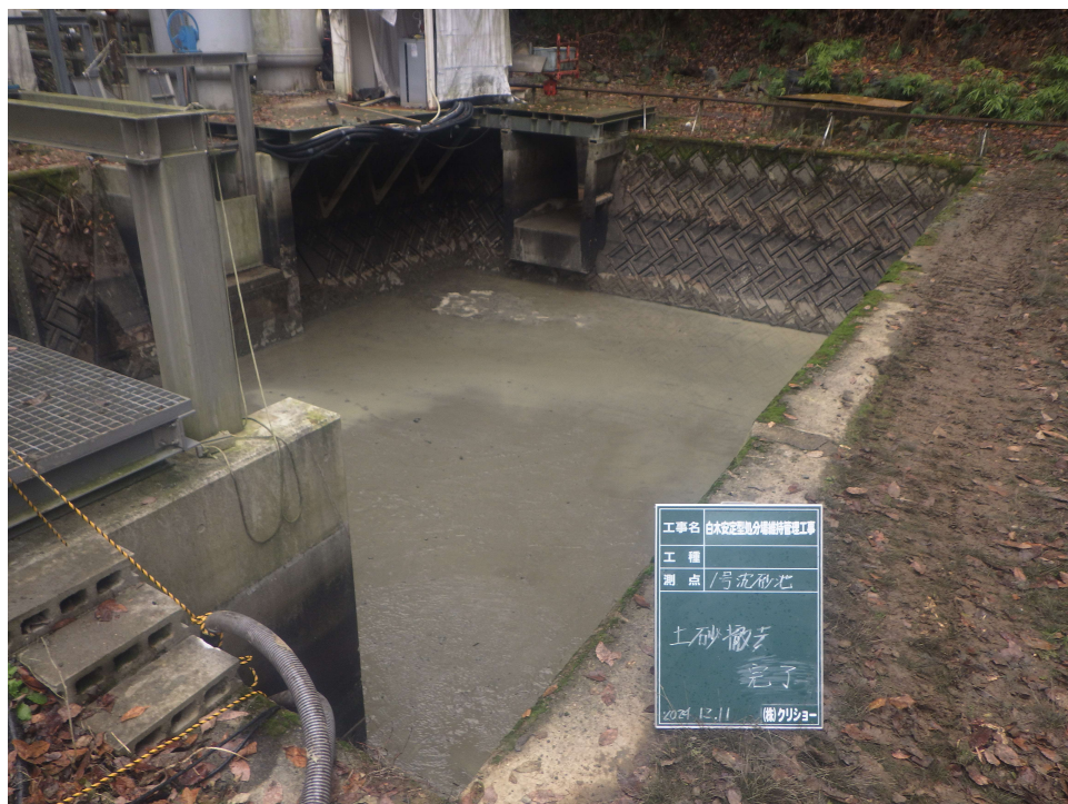
沈砂池 土砂撤去完了 (2024年12月10日～2024年12月11日)
