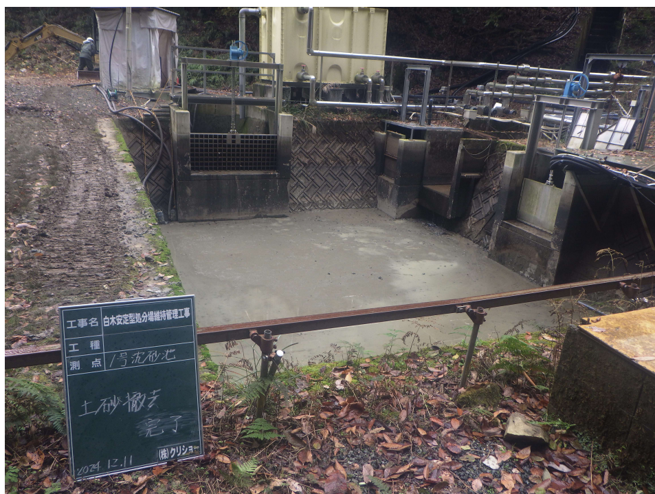
沈砂池 土砂撤去完了 (2024年12月10日～2024年12月11日)
