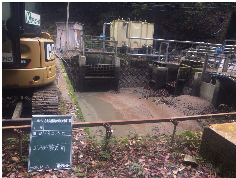
沈砂池 土砂撤去前 (2024年12月10日～2024年12月11日)
