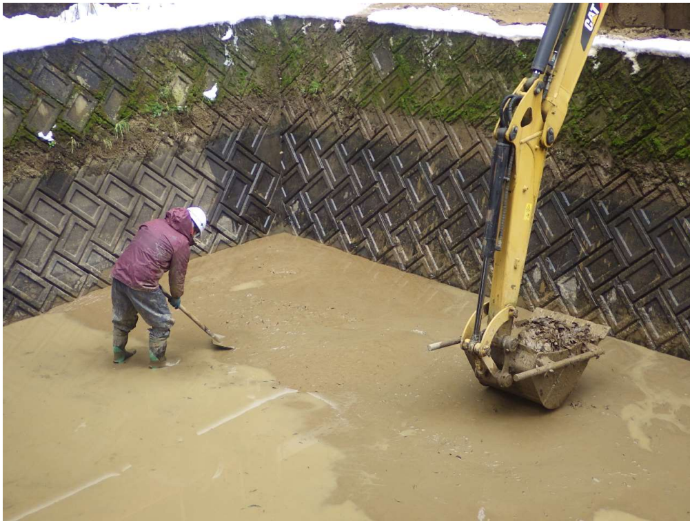
沈砂池清掃 沈砂池 土砂撤去状況
