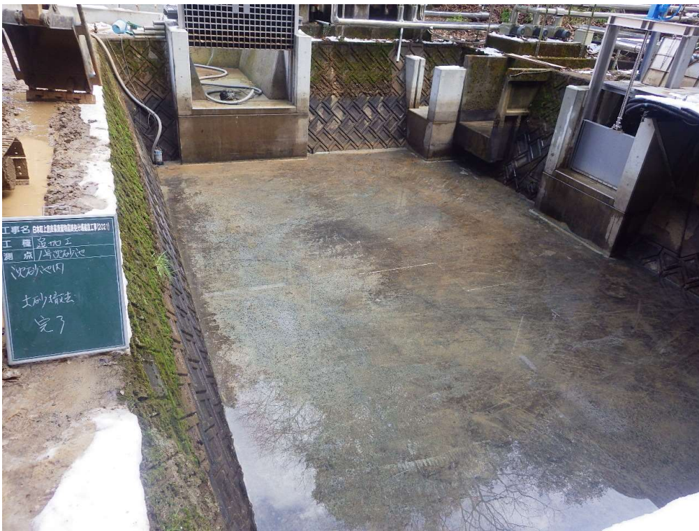
沈砂池 土砂撤去完了
