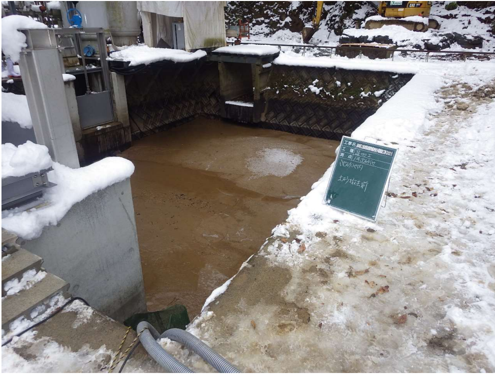
沈砂池 土砂撤去前
