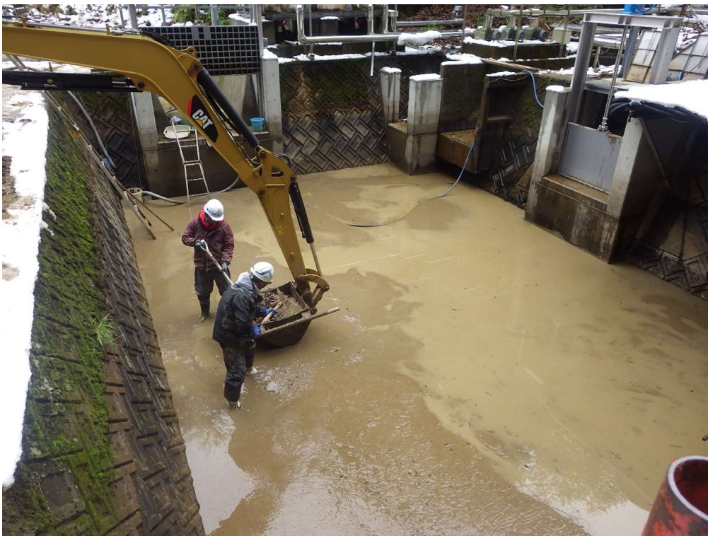
沈砂池清掃 沈砂池 土砂撤去状況
