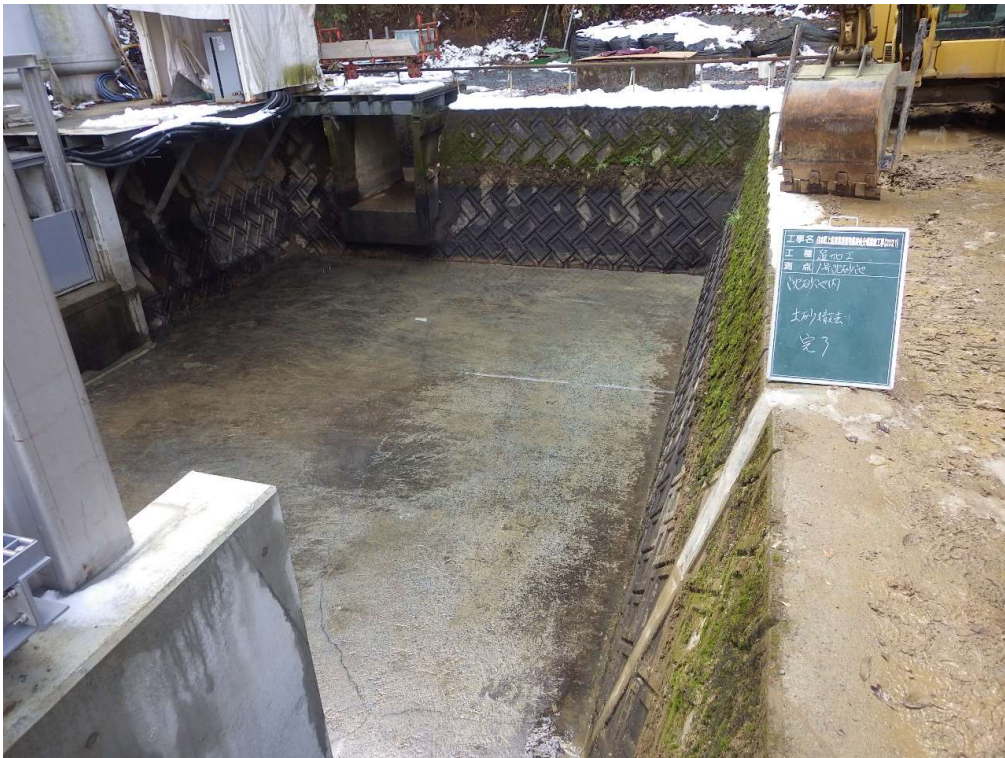
沈砂池 土砂撤去完了
