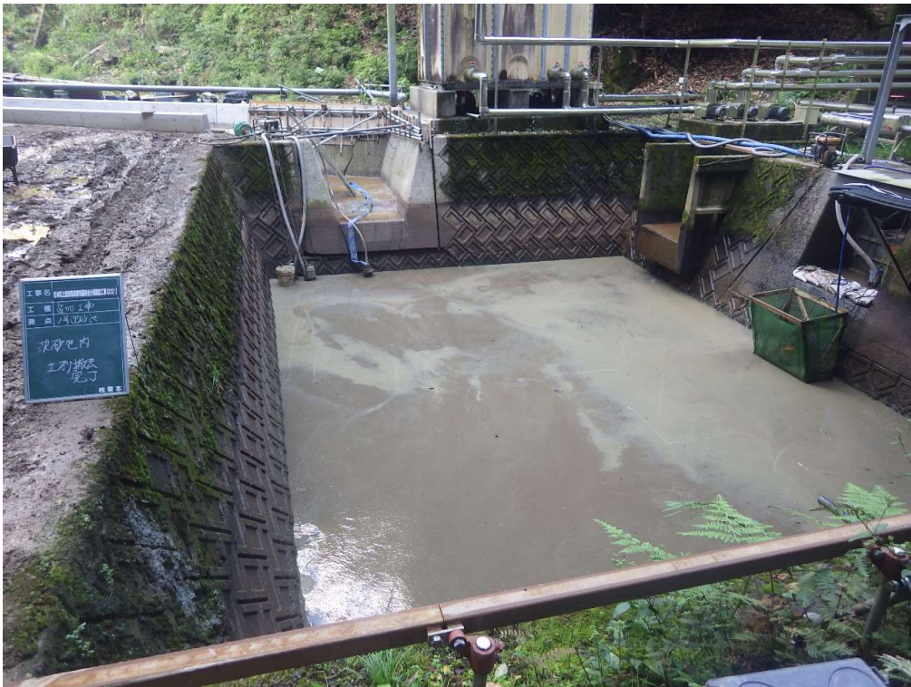
沈砂池 土砂撤去完了
