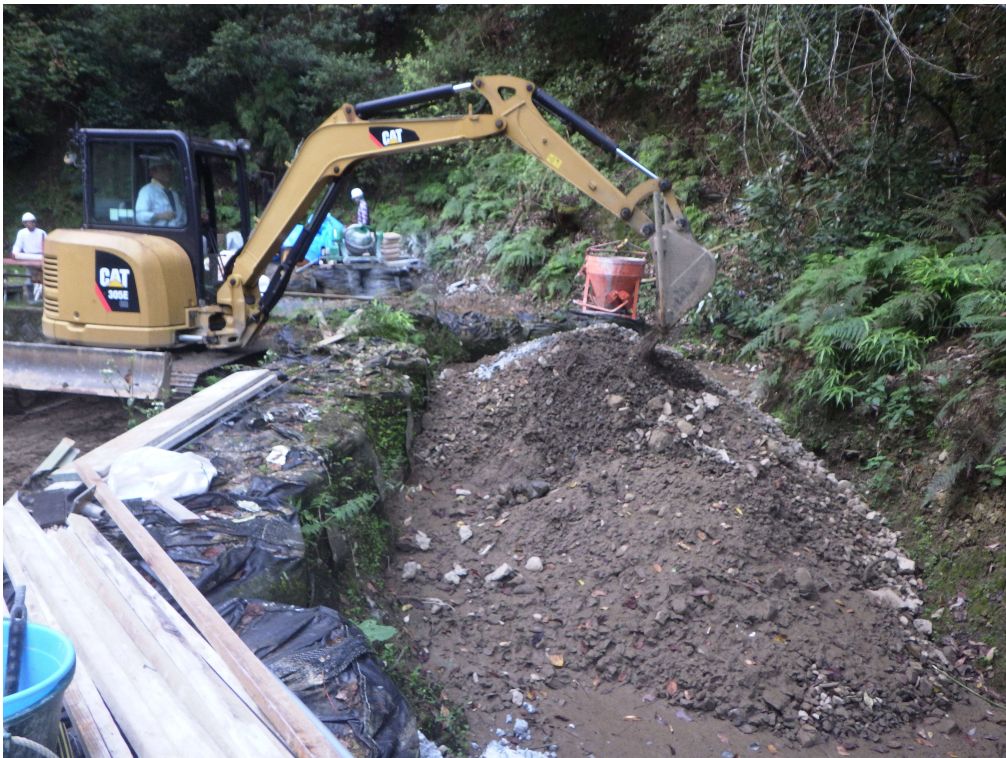
沈砂池清掃 仮置部 土砂撤去状況
