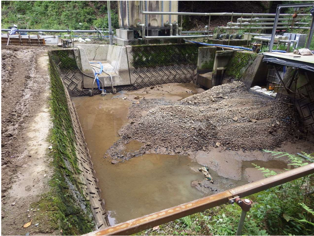
沈砂池 土砂撤去前
