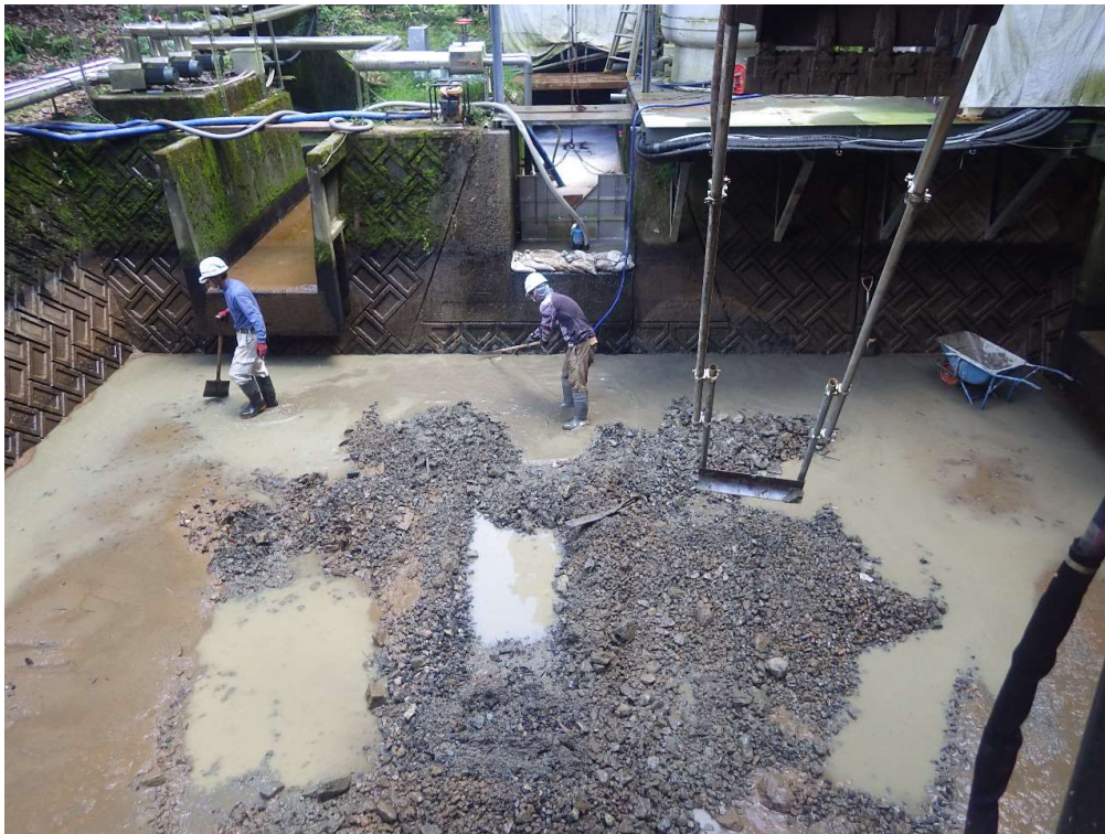
沈砂池清掃 仮置部 土砂撤去状況
