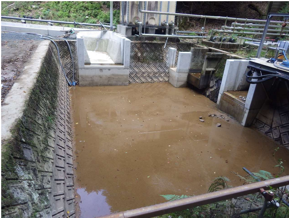
沈砂池 土砂撤去前
