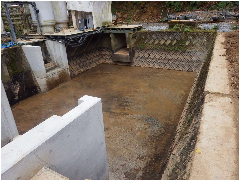
沈砂池 土砂撤去完了
