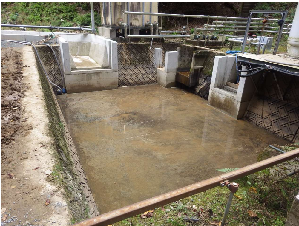
沈砂池 土砂撤去完了
