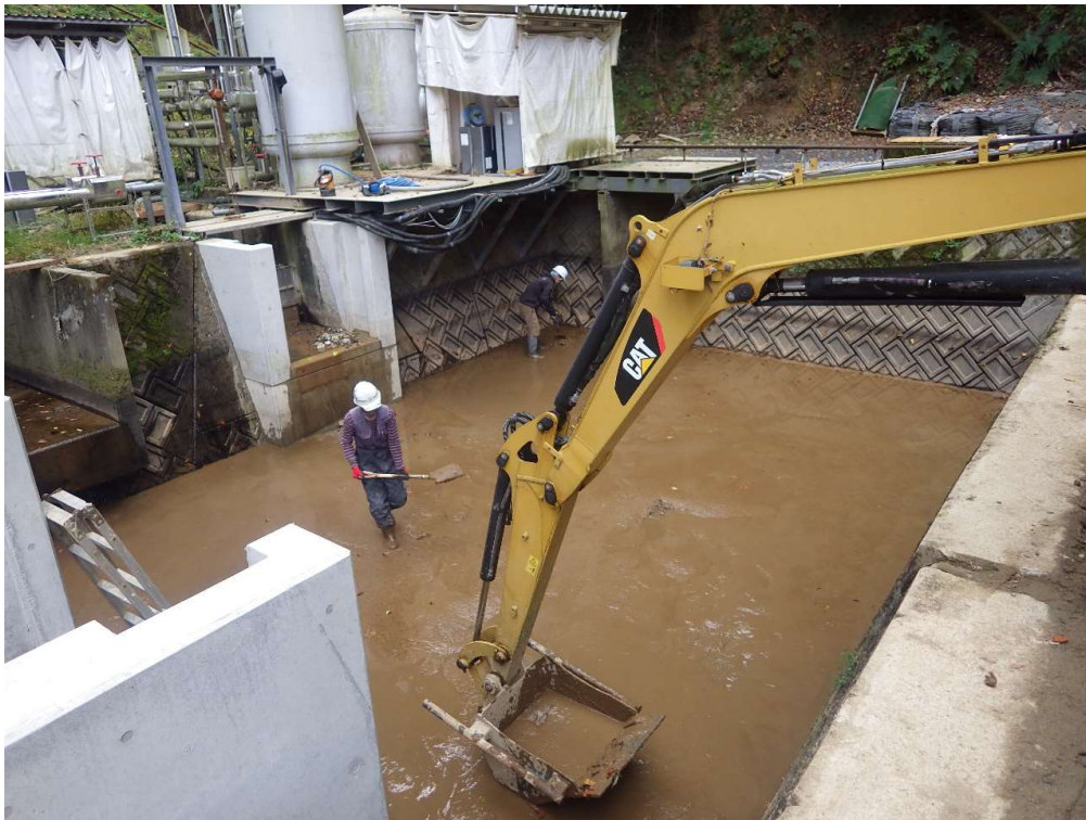
沈砂池清掃 沈砂池 土砂撤去状況
