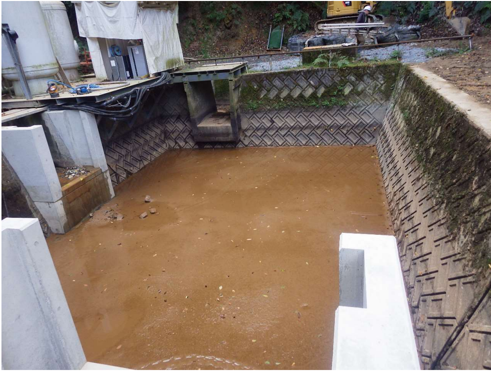
沈砂池 土砂撤去前
