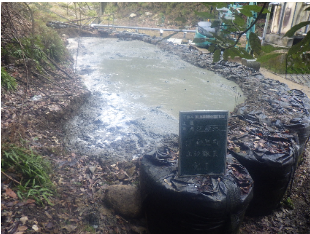
沈砂池清掃 沈砂池 土砂撤去状況
