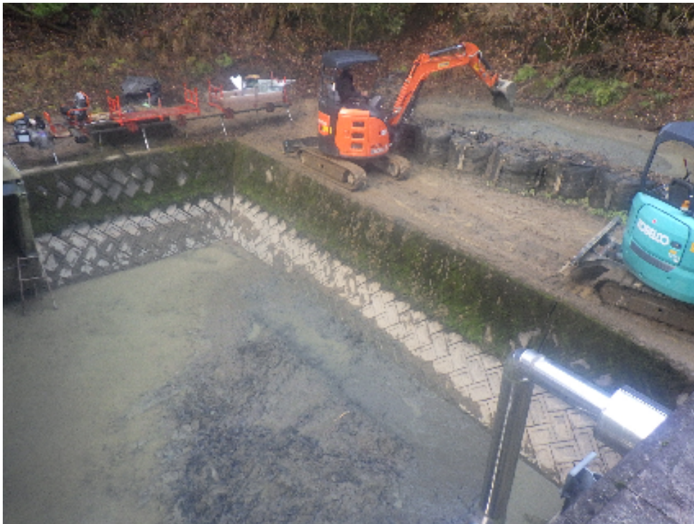
沈砂池清掃 沈砂池 土砂撤去状況
