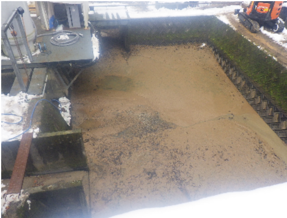
沈砂池 土砂撤去前
