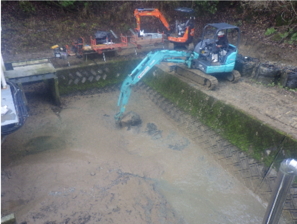
沈砂池清掃 沈砂池 土砂撤去状況
