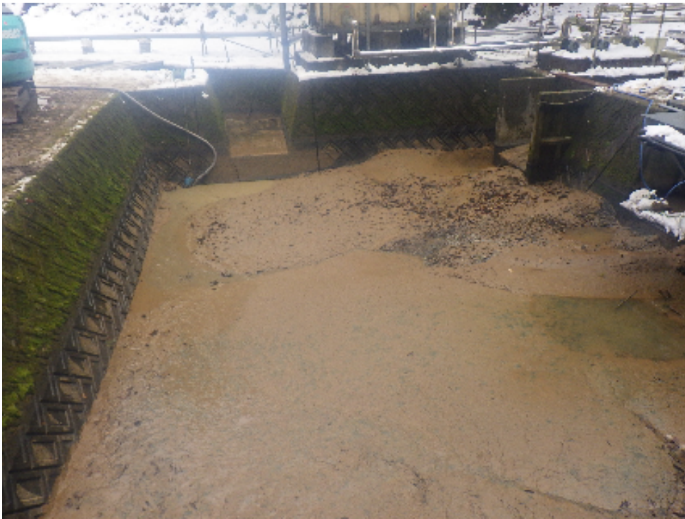
沈砂池 土砂撤去前
