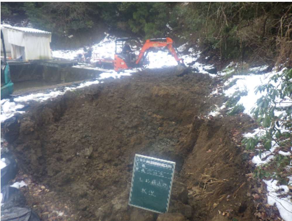
沈砂池清掃 仮置部 土砂撤去状況
