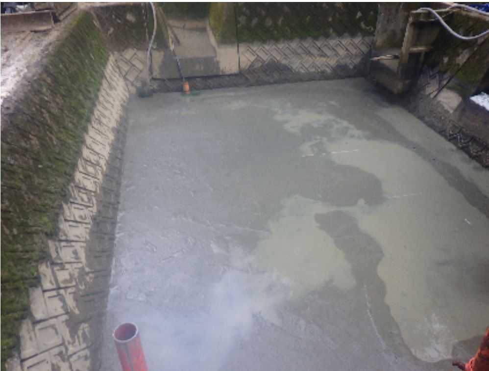
沈砂池 土砂撤去完了
