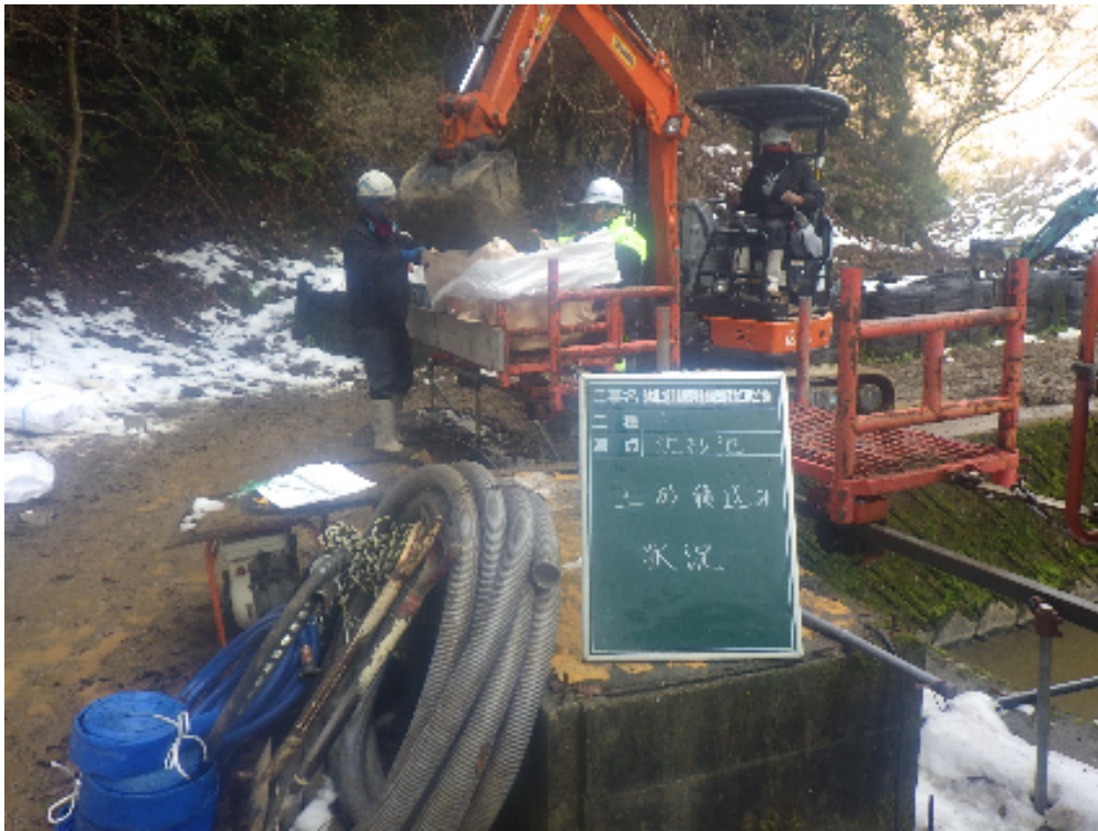
沈砂池清掃 仮置部 土砂撤去状況
