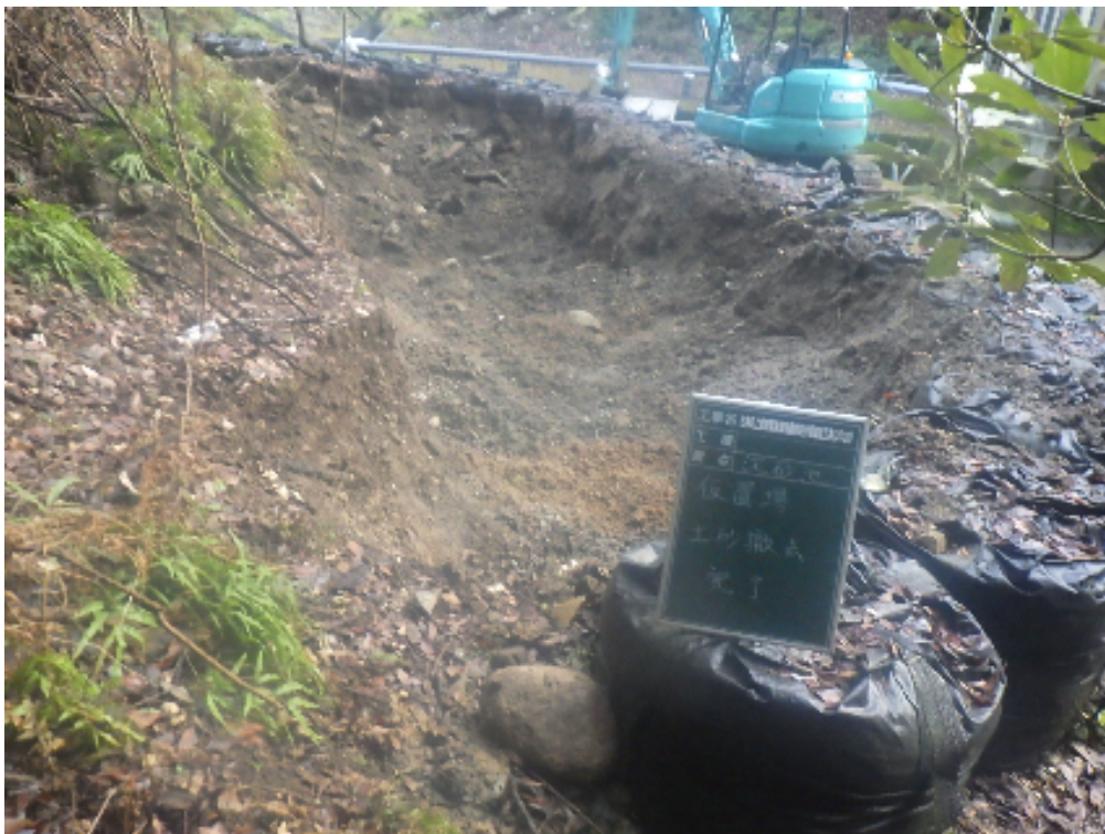
沈砂池清掃 仮置部 土砂撤去完了
