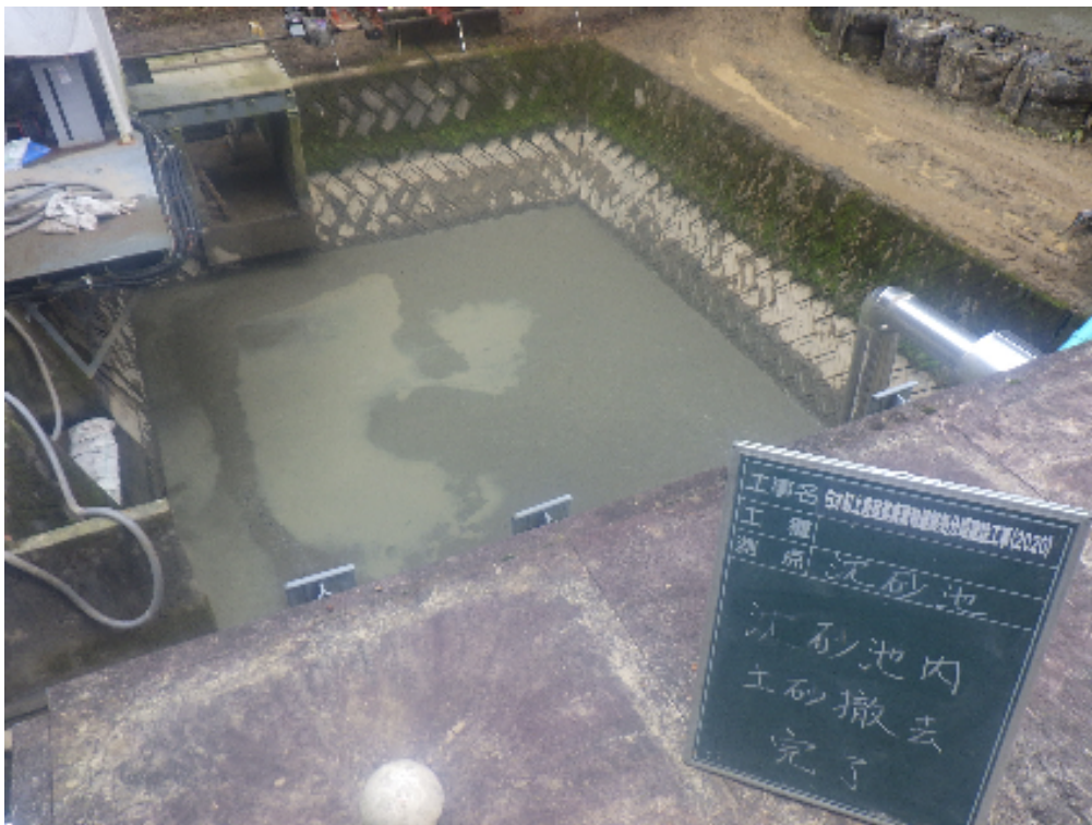
沈砂池 土砂撤去完了
