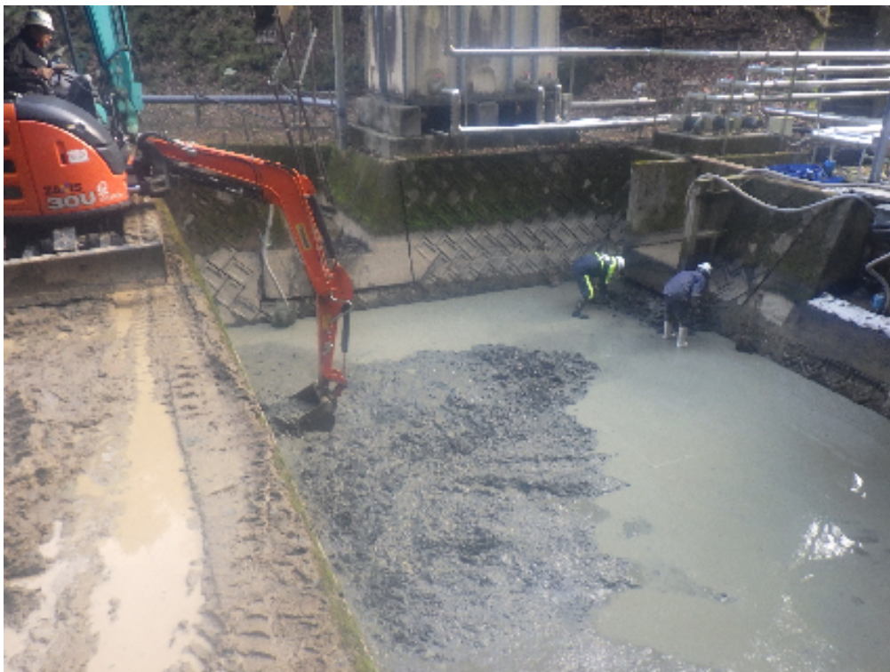
沈砂池清掃 沈砂池 土砂撤去状況
